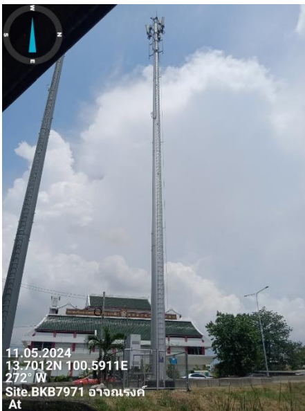
รูป A เสา Tower
