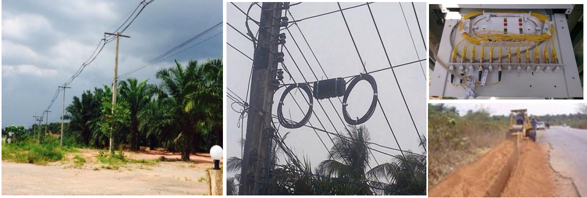
ภาพตัวอย่างการวางสายเคเบิลใยแก้วนำแสง
